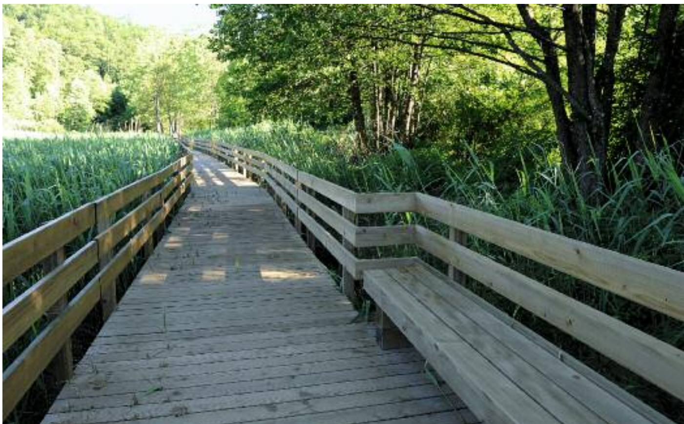
180 m de long sur 2 m de large, l'ouvrage se fraie un chemin dans les herbes. Sa pose a été réalisée en trois jours par six monteurs, rapidité imposée par les us animaliers de printemps qu'il ne fallait pas déranger et par la nécessité de minimiser l'impact sur l'environnement.
